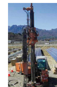
【バーカッションドリルによる掘削作業】
