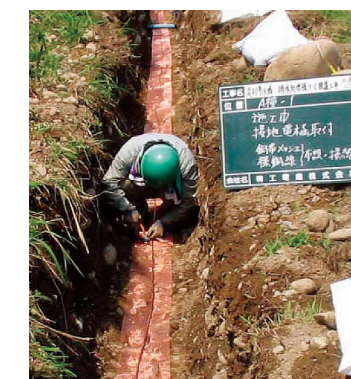
2~3日後には土中の水分により、ホクデンEP-1が凝固し、網・銅線とが一体となった導電性接地電極を形成します。
